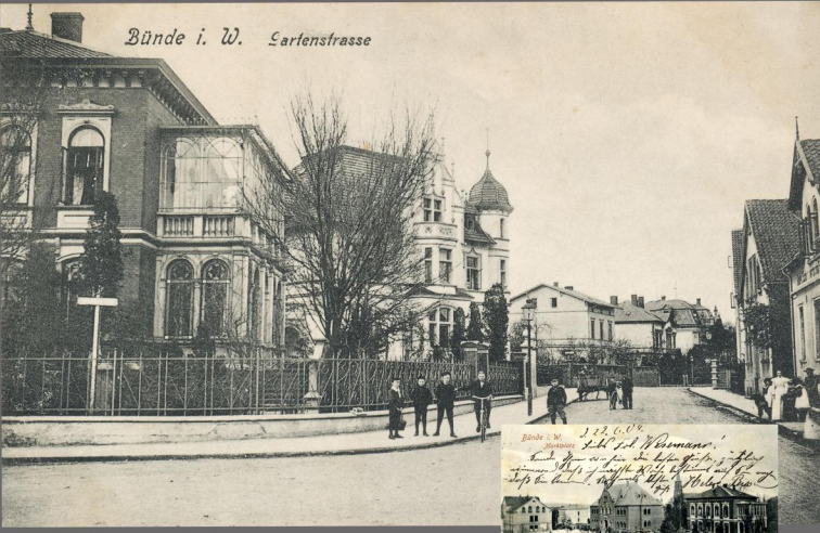
Blick von der Marktstraße in die heutige Hindenburgstraße. Die damalige Gartenstraße zählte zu den ersten Adressen, links die Villa der Familie Levison (Slg. Schürmann im Archiv Miltzer)
