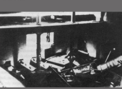
Der Giebel ohne Davidstern, der zertrümmerte Innenraum und die zerplatzten Fenster, Fotos von Bernhard Heinemann (STANRWDT und KAH)
