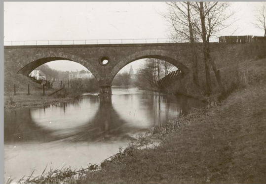
Eisenbahnbrücke über die Aa, Foto: Kommunalarchiv
