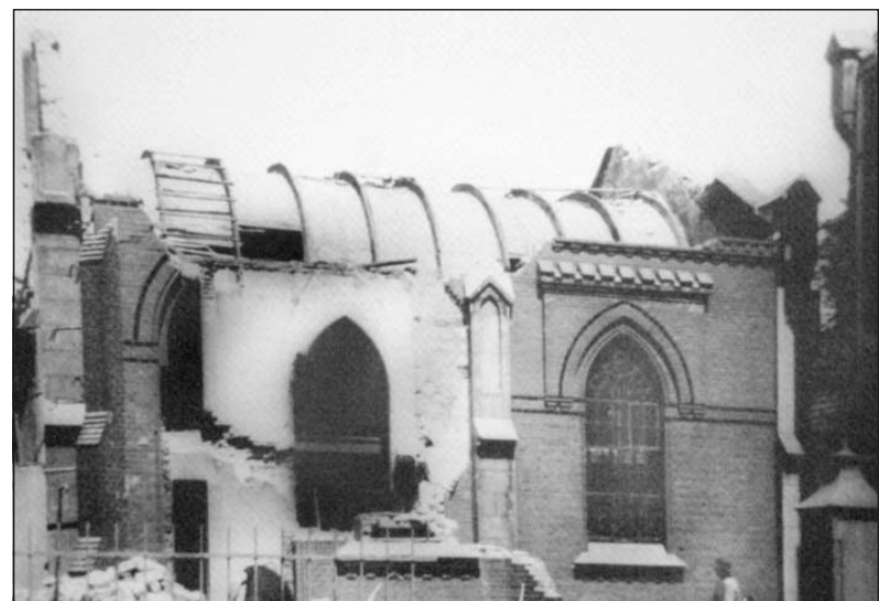
Herfords Synagoge brannte zweimal: Bereits 1934 hatten hier SA-Männer einen Brand gelegt. 1938 wurde die Synagoge zerstört. Anfang 1939 wurde die jüdische Gemeinde gezwungen, die Synagoge abzureißen.
